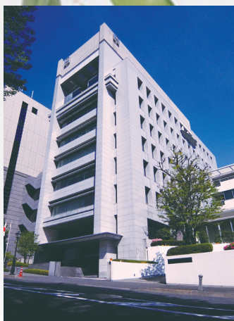
ハウス食品(株)本社ビル
